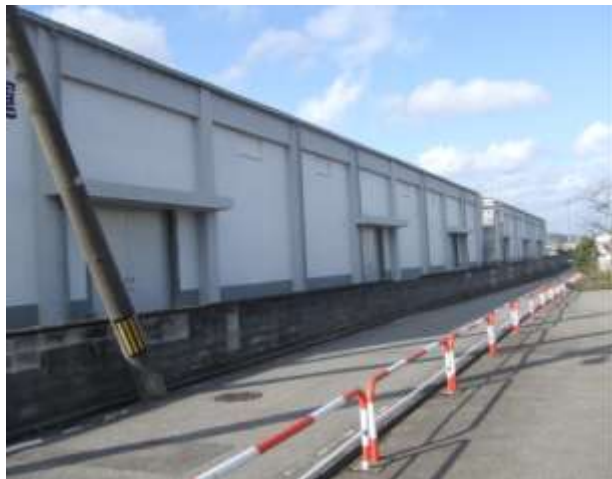
N社物流倉庫外壁 RC、スレート、角波
